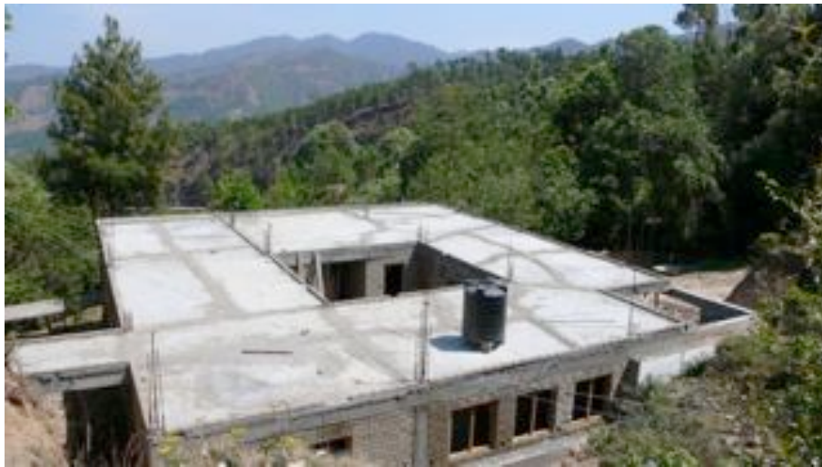
La nouvelle résidence des étudiants en construction
