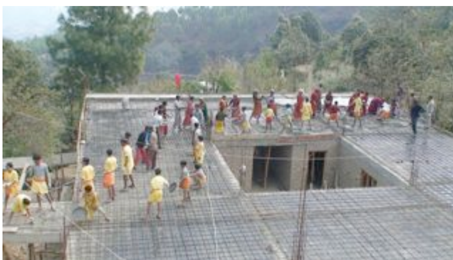
Les étudiants participent à la construction de leur nouvelle résidence, en faisant la chaîne pour apporter les paniers de béton pour couler la dalle.
